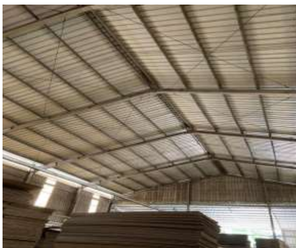
Hình 11. Bố trí nhà xưởng cao ráo, thiết kế 2 mái tạo thông thoáng toàn xưởng
