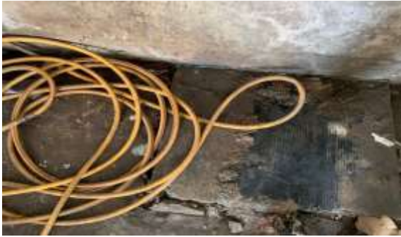
Hố ga thoát nước bên trong Công ty
