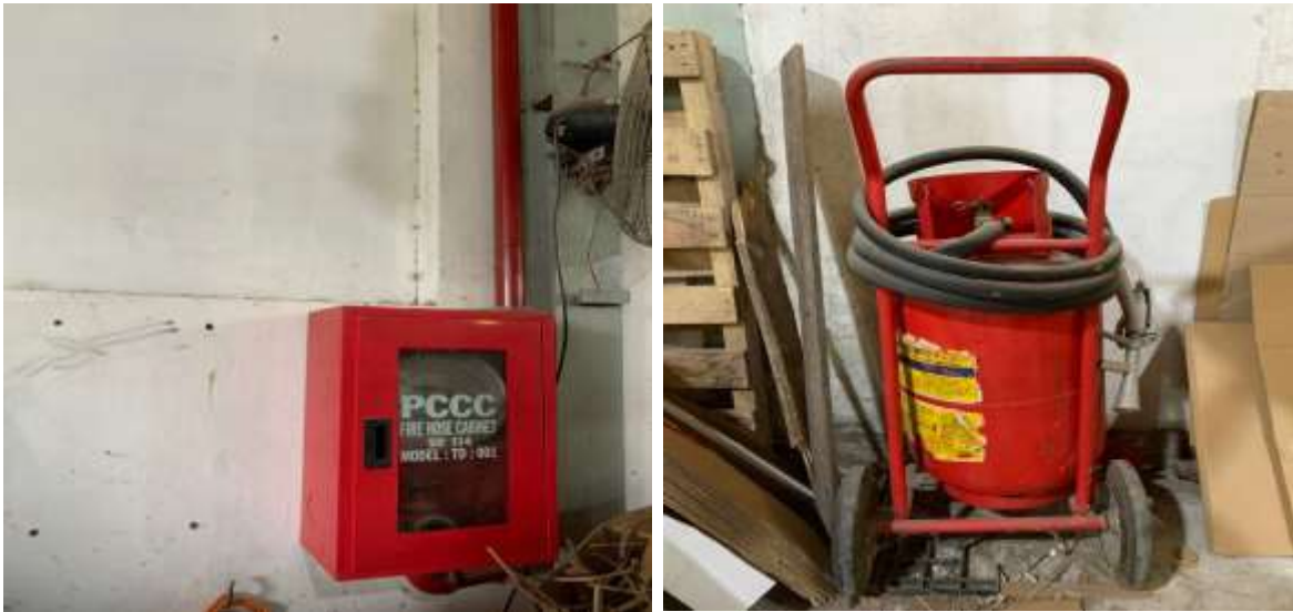
Hình 16. Thiết bị PCCC của Công ty
