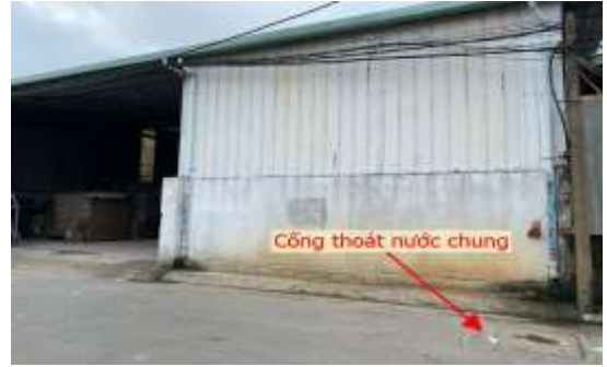
Cổng thoát nước chung trên đường Thanh Xuân 21
