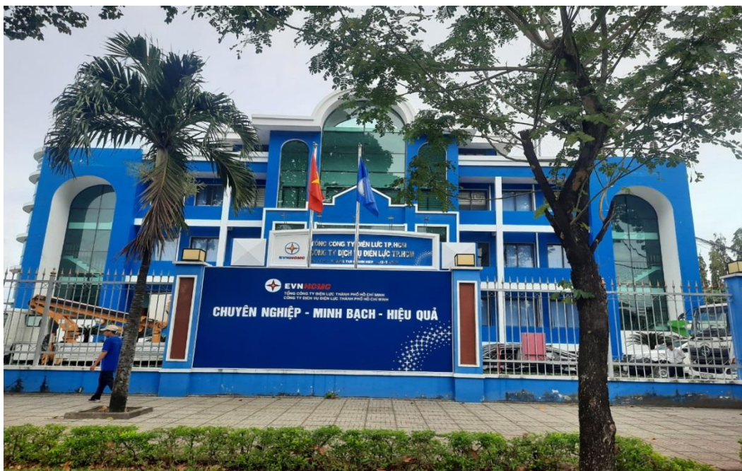
Hình 2: Hiện trạng của Khu nhà điều hành
