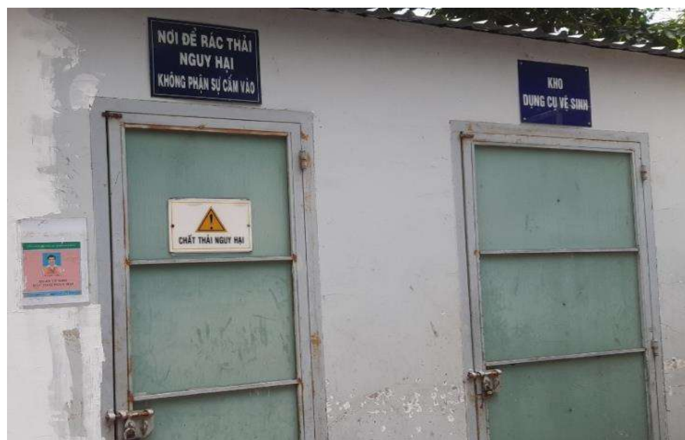
Hình 3.13. Khu vực kho chứa CTNH của Công ty
