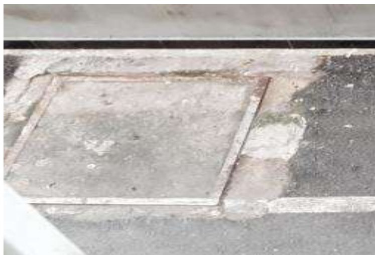
Hình 3.1. Cống thoát nước mưa xung quanh khu vực sản xuất của cơ sở
