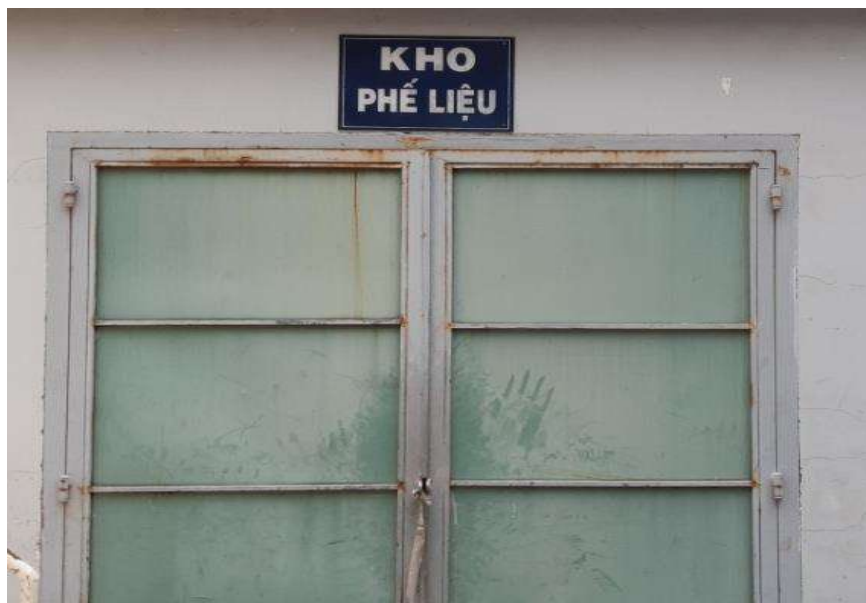
Hình 3.12. Kho phế liệu chứa chất thải công nghiệp thông thường của Công ty Thống kê chất thải phát sinh tại Công ty:
